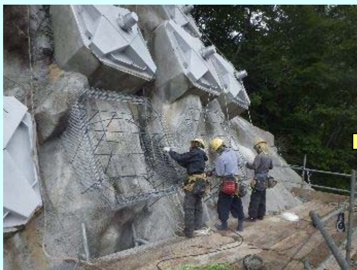
写真1：エフケー不陸調整枠設置状況
