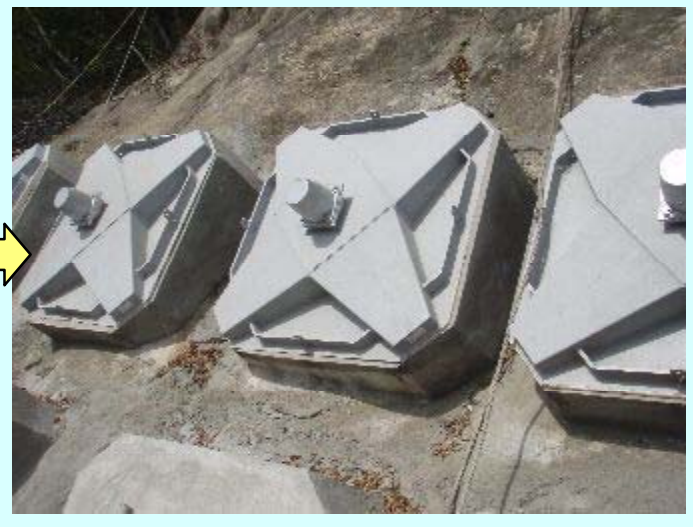
写真6：受圧板設置完了
