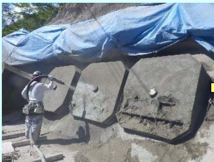
写真3：モルタル吹付状況
