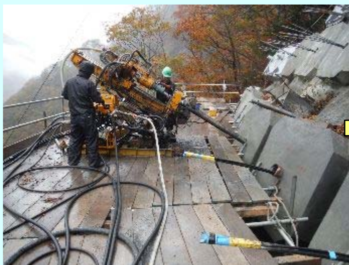
写真5：グラウンドアンカーの施工状況
