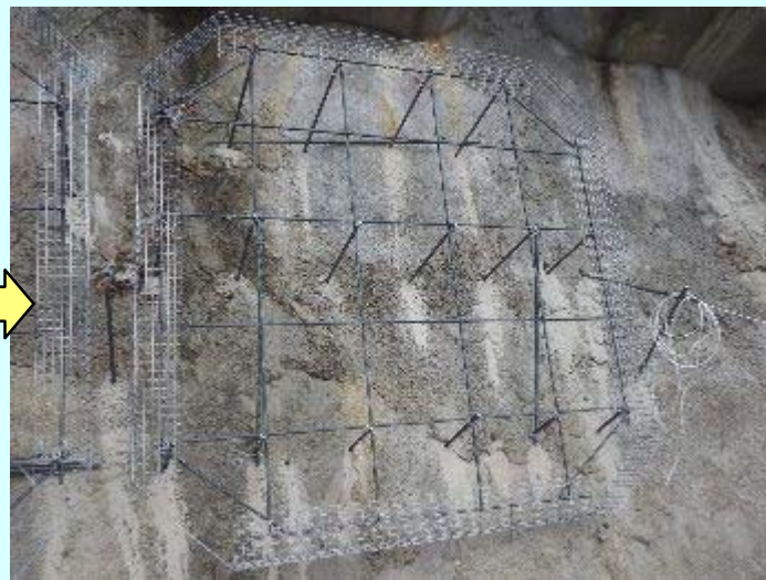
写真2：エフケー不陸調整枠設置完了
