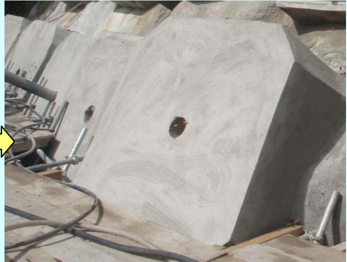
写真4：モルタル吹付完了
