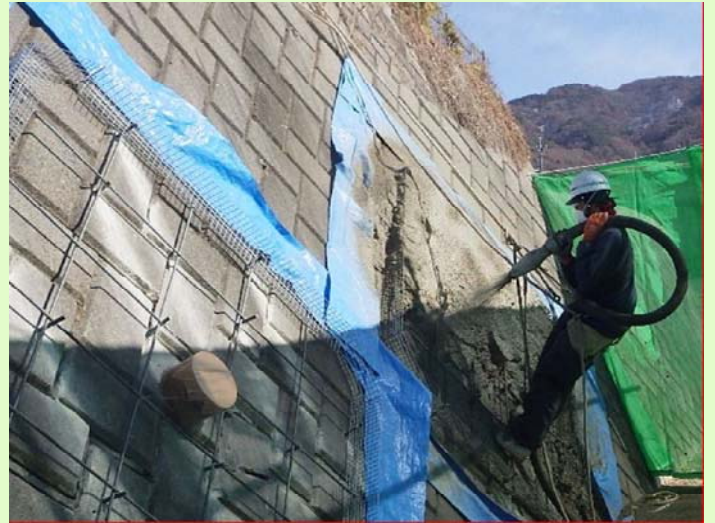
写真1: エフケー不陸調整枠設置、 モルタル吹付状況
