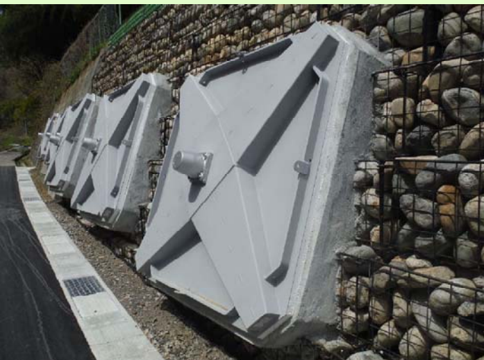
写真3: 受圧板設置完了
