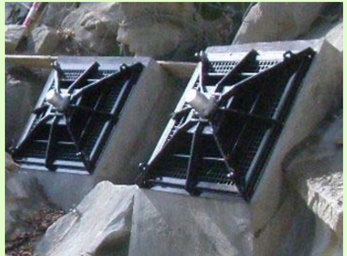
写真3：受圧板設置完了
