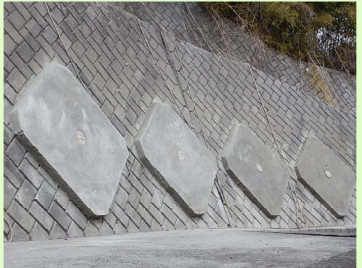
写真2: モルタル吹付完了
