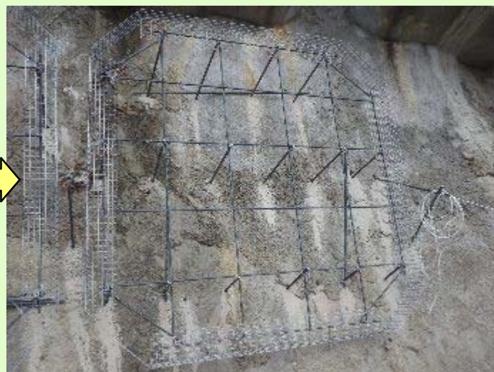
写真2：不陸調整枠設置完了
