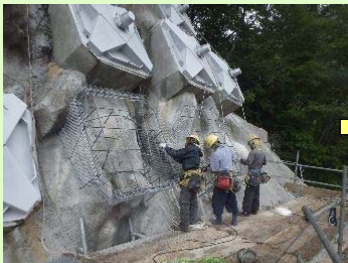
写真1：エフケー不陸調整枠設置状況
