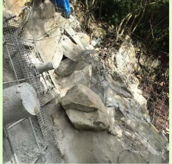
写真1：エフケー不陸調整枠設置
