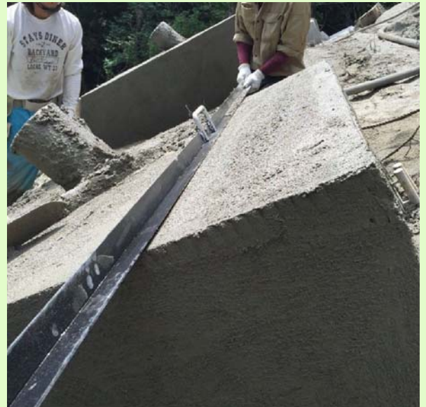
写真2：専用定規材による表面コテ仕上げ状
