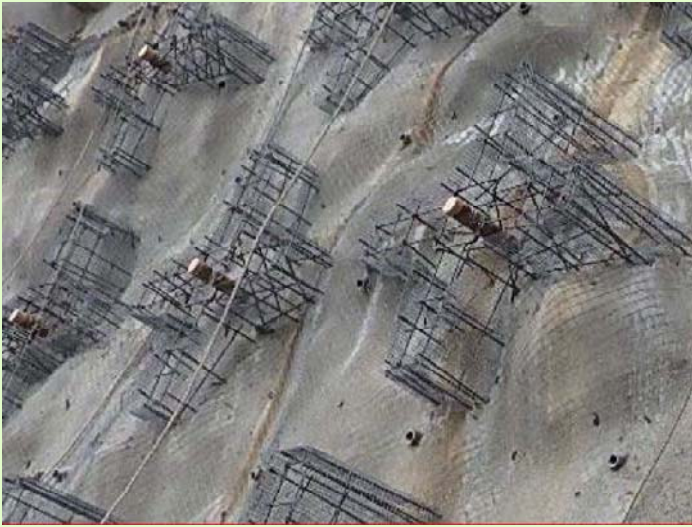
写真1：エフケー不陸調整枠設置
