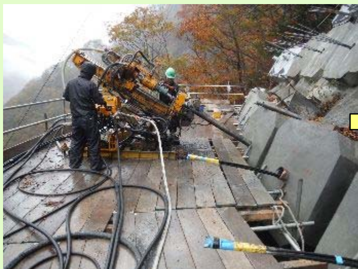
写真5：グラウンドアンカー施工状況
