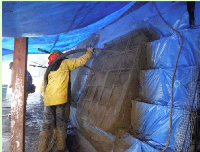
写真2: モルタル吹付状況
