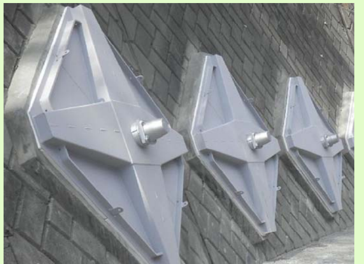
写真3: 受圧板設置完了
