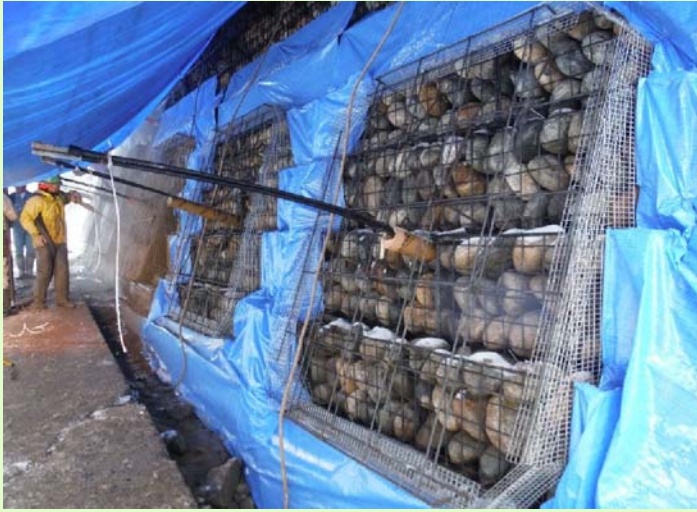
写真1: エフケー不陸調整枠設置
