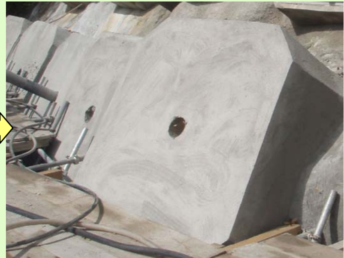
写真4：モルタル吹付完了
