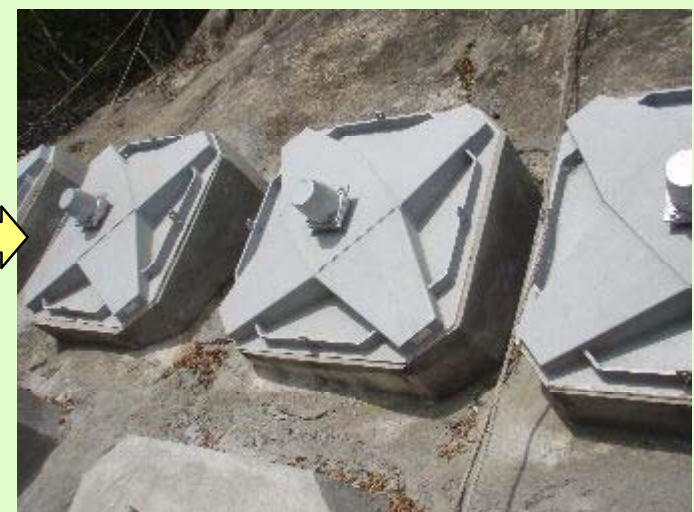
写真6：受圧板設置完了
